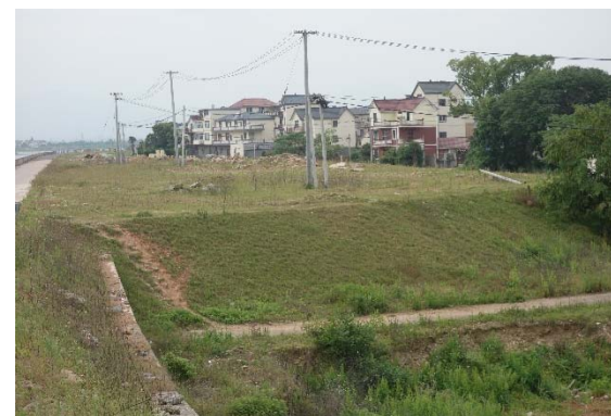
船闸场内道路草皮护坡 (2019.5)
