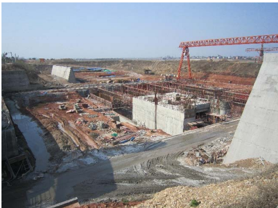
电站厂房施工 (2014.3)
