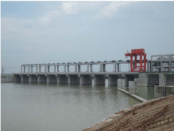
电站及右侧泄洪闸上部施工 (2015.6)
