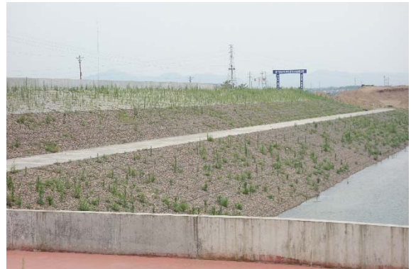
左岸下游防洪堤 (2016.7)
