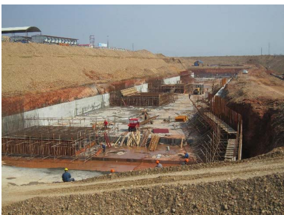
左岸船闸引航道基础施工 (2014.3)
