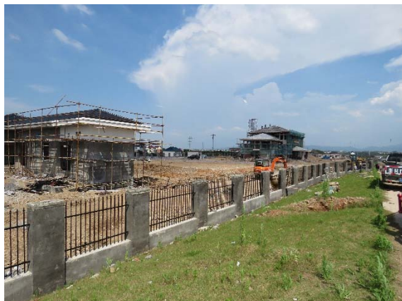
船闸管理房施工 (2018.7)
