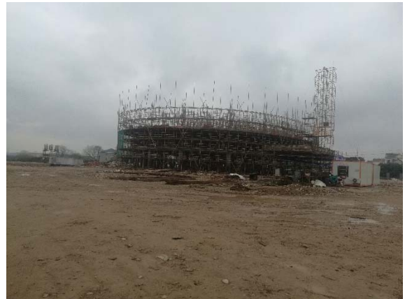
电站管理房施工 (2016.12)
