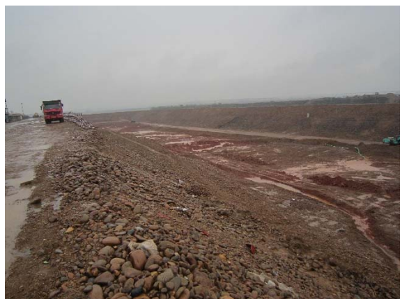
船闸及引航道基坑开挖 (2013.12)
