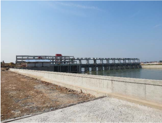
电站及右侧泄洪闸上部施工 (2015.9)
