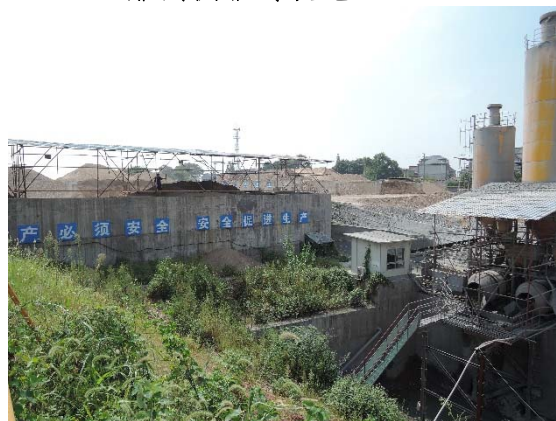
电站侧临时设施区 (2014.9)
