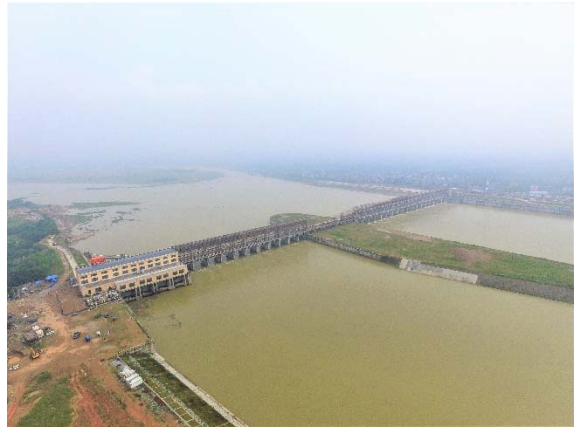
图 1-3 无人机调查、巡查应用情况
