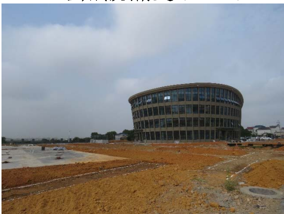
电站管理区覆耕植土 (2017.3)
