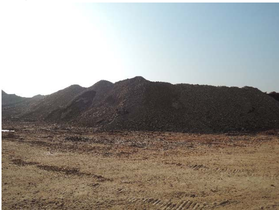
电站管理区临时堆场 (2014.12)
