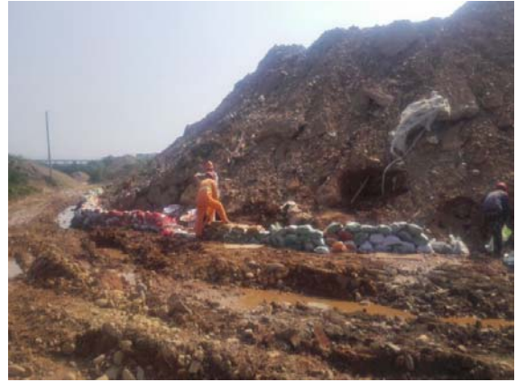
临时堆土场拦挡、排水施工 (2015.9)
