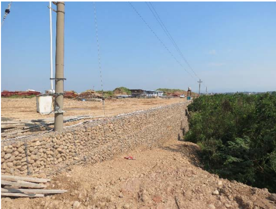
电站管理区钢丝笼挡墙 (2015.10)
