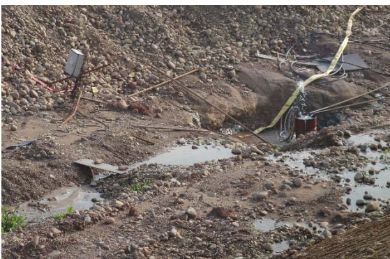
左岸泄洪闸基坑内沉沙池 (2015.12)
