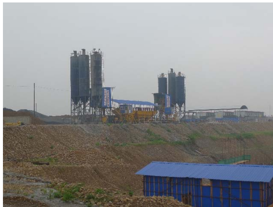
船闸侧临时设施区 (2014.6)
