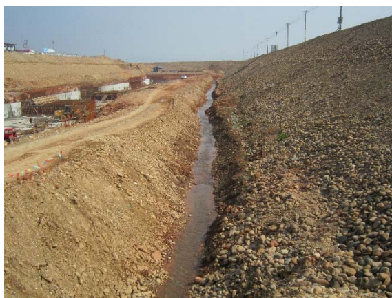
船闸引航道基坑临时排水沟 (2014.3)
