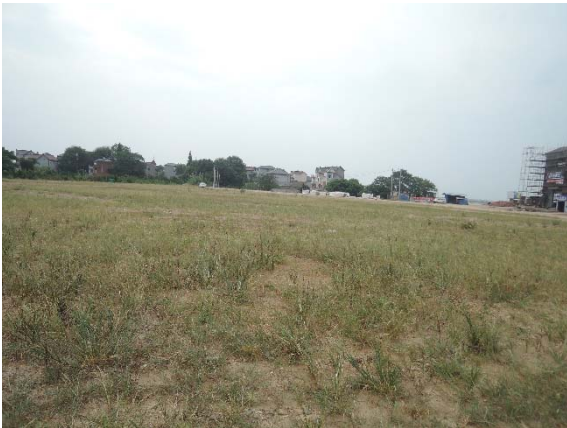
电站管理区场地平整 (2016.9)
