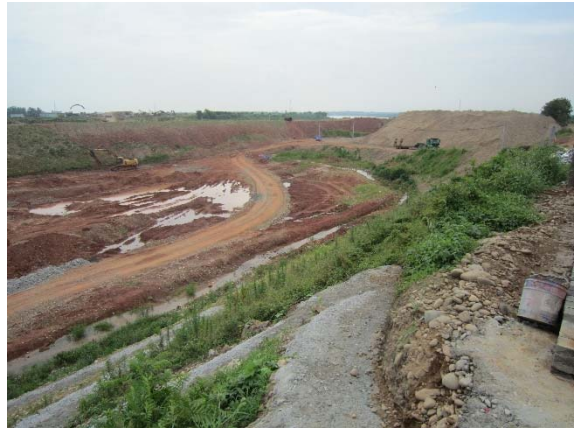
电站基坑内临时排水沟 (2013.7)
