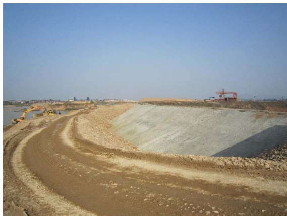
围堰喷砂护坡 (2014.4)
