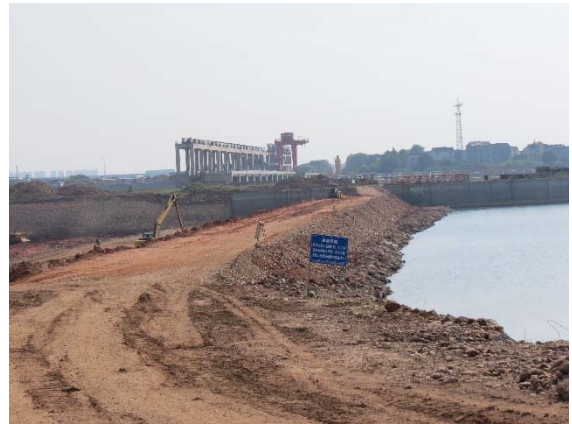
左岸泄洪闸围堰 (2015.10)
