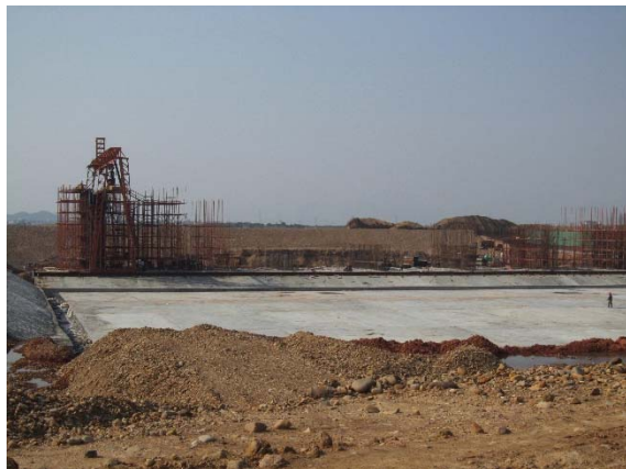
右侧泄洪闸基础施工 (2014.3)
