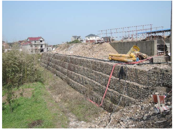
船闸管理区钢丝笼挡墙 (2015.4)
