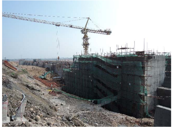
船闸及引航道施工 (2015.3)
