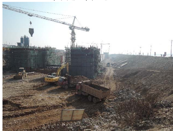
船闸引航道施工 (2014.12)
