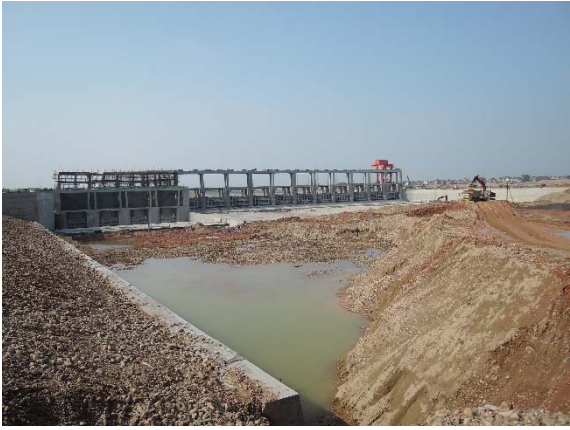
电站及右侧泄洪闸施工 (2015.3)
