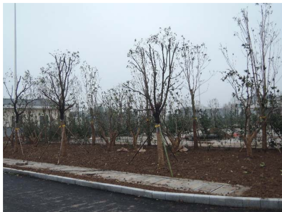
船闸管理区绿化施工 (2018.12)
