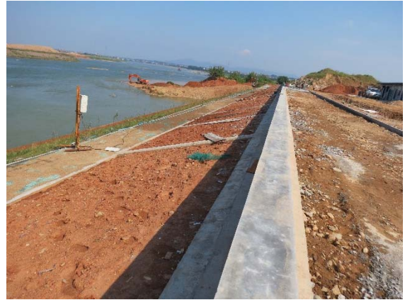
右岸下游防洪堤覆种植土 (2015.9)
