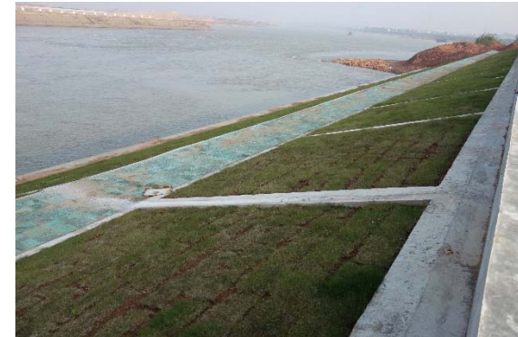
右岸下游防洪堤草皮护坡 (2015.12)
