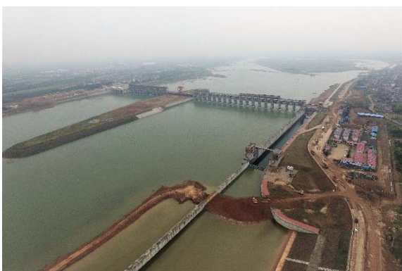
泄洪闸及引航道 (2017.3)
