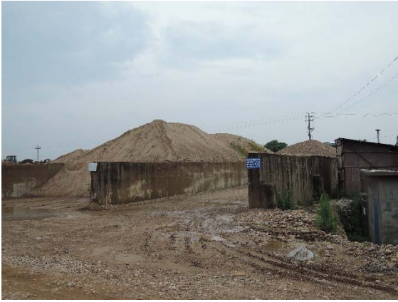
电站管理区砂石料堆场 (2015.8)
