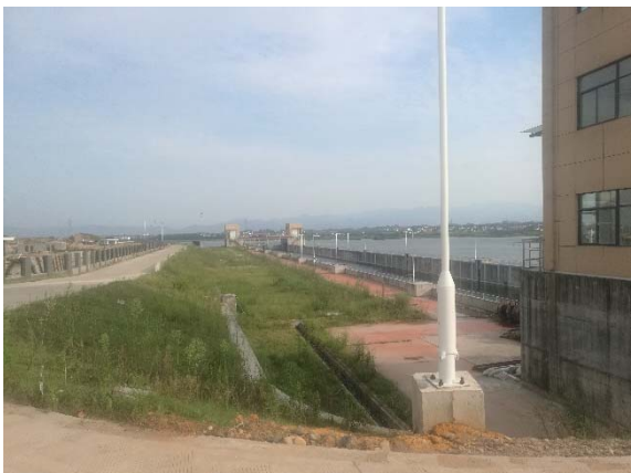
船闸场内道路草皮护坡 (2018.9)
