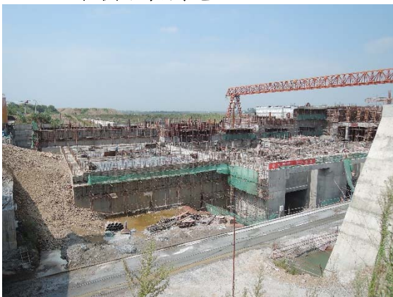
电站厂房施工 (2014.9)
