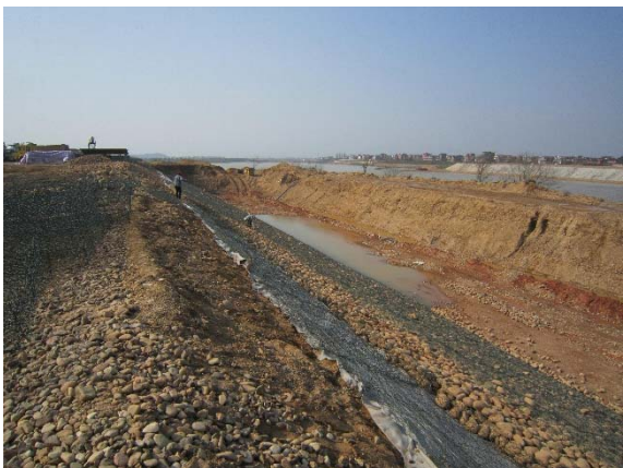
江心洲生态网格护坡施工 (2014.4)
