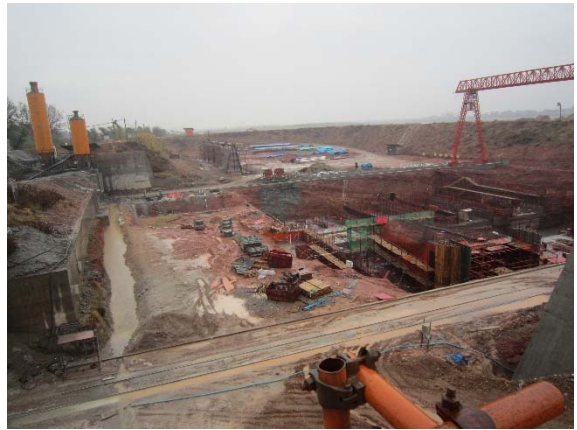
电站厂房基础施工 (2013.9)
