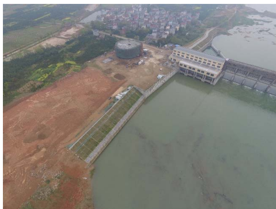
右岸电站厂房及管理区 (2017.3)
