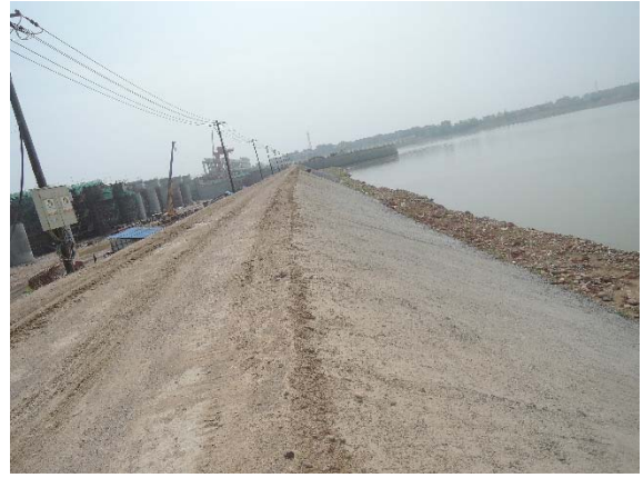
左侧泄洪闸围堰喷砂护坡 (2016.3)
