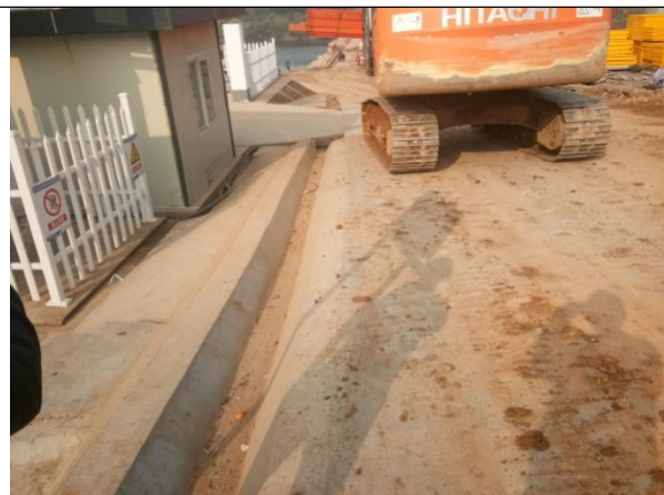
图 3-1 施工场地临时排水沟
