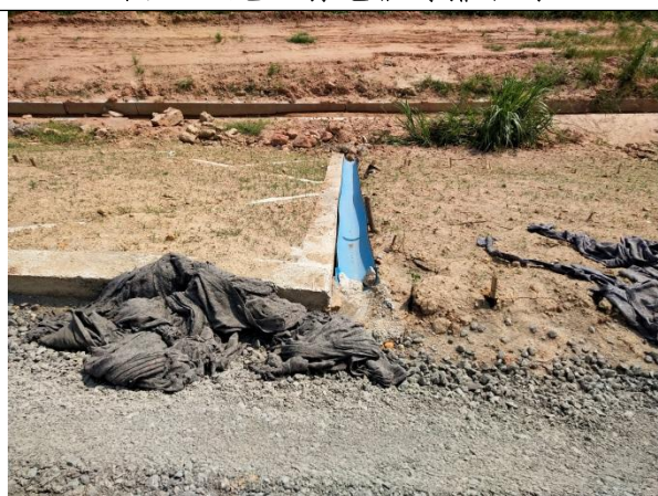
图 3-4 路堤边坡急流槽
