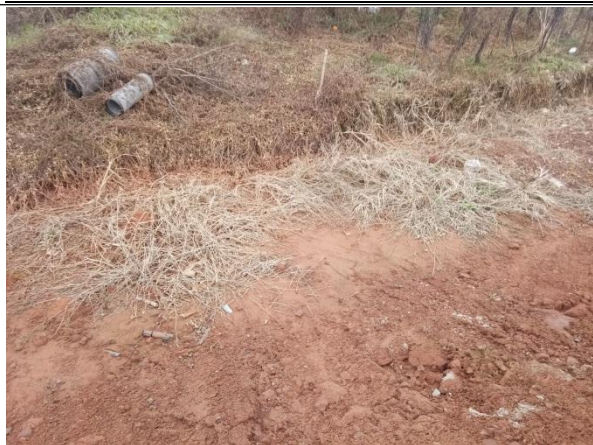
图 3-7 路基两侧临时排水沟
