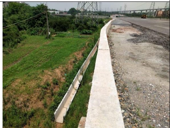
图 6 主线路基两侧排水沟
