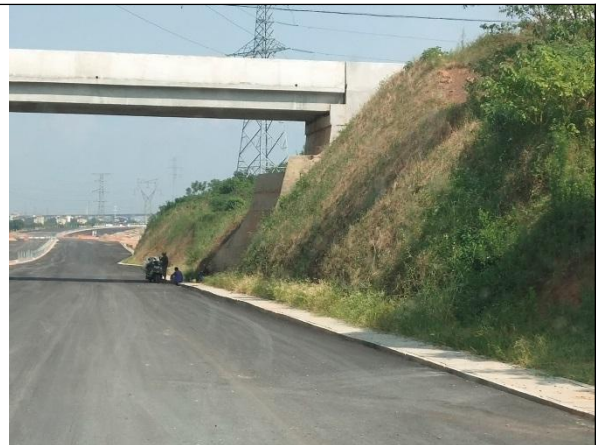
图 2 路堑边坡绿化及下方边沟
