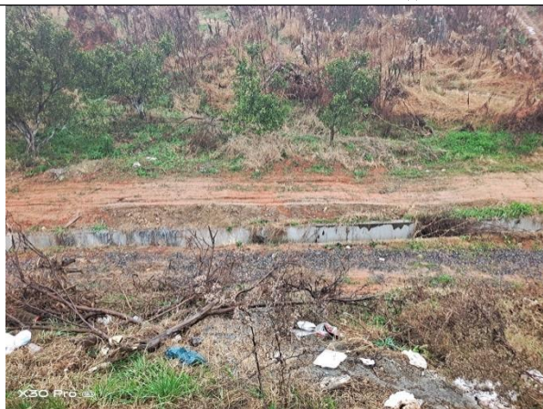
图 3-6 路堤边坡下方排水沟
