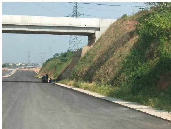
图 3-10 路堑边坡绿化及坡脚边沟
