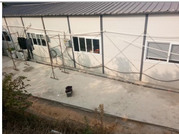
图 3-2 施工场地临时排水沟
