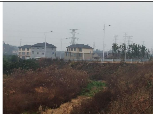
图 3-5 路堤边坡绿化
