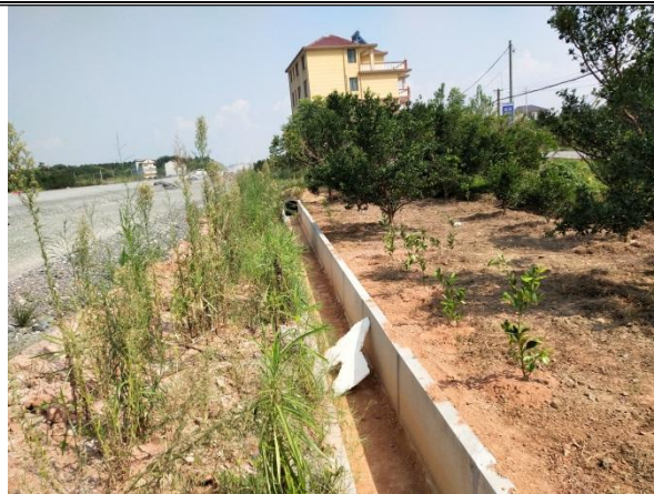
图 3-8 路基两侧排水沟
