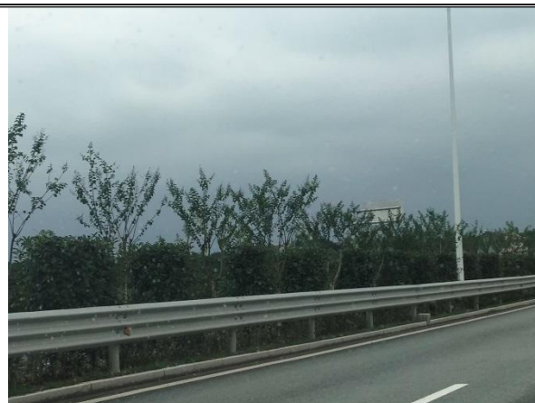
图 3-14 中央分隔带综合绿化
