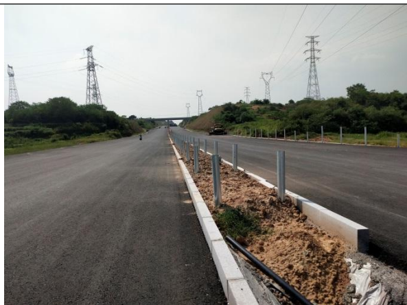
图 3-11 中央分隔带绿化覆土
