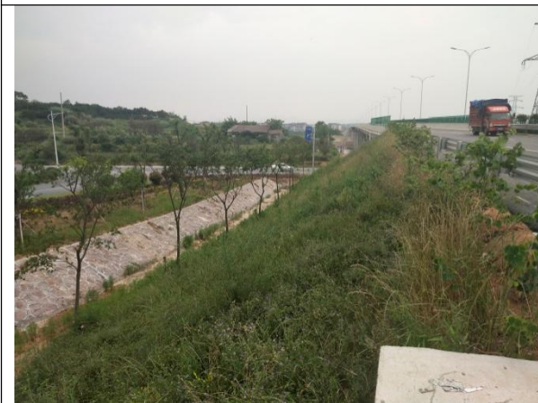
图 5 下缪大桥桥头锥坡绿化
