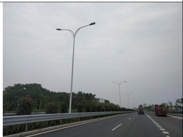
图 4 中央分隔带综合绿化
