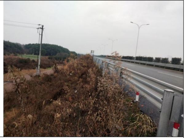
图 8 路堤边坡绿化
